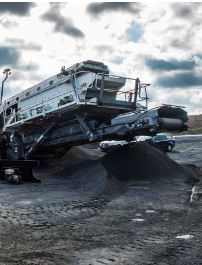
Oprava dopravníkového pásu v kamenolomu
