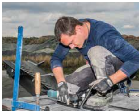
Příprava spoje dopravníkového pásu
